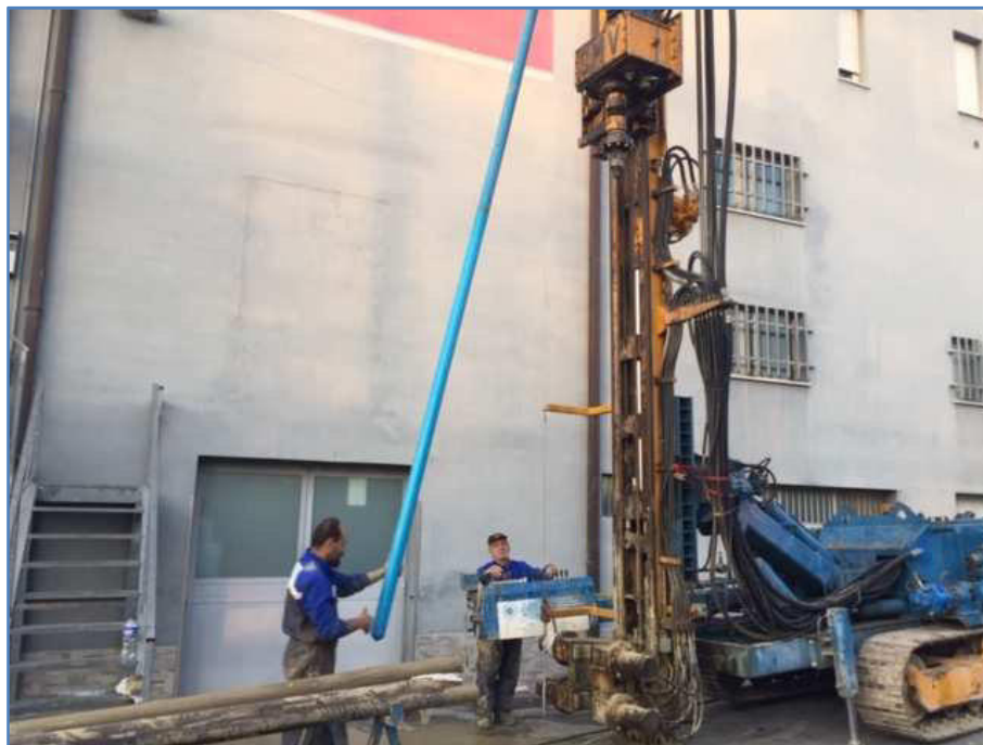
Installazione piezometro
