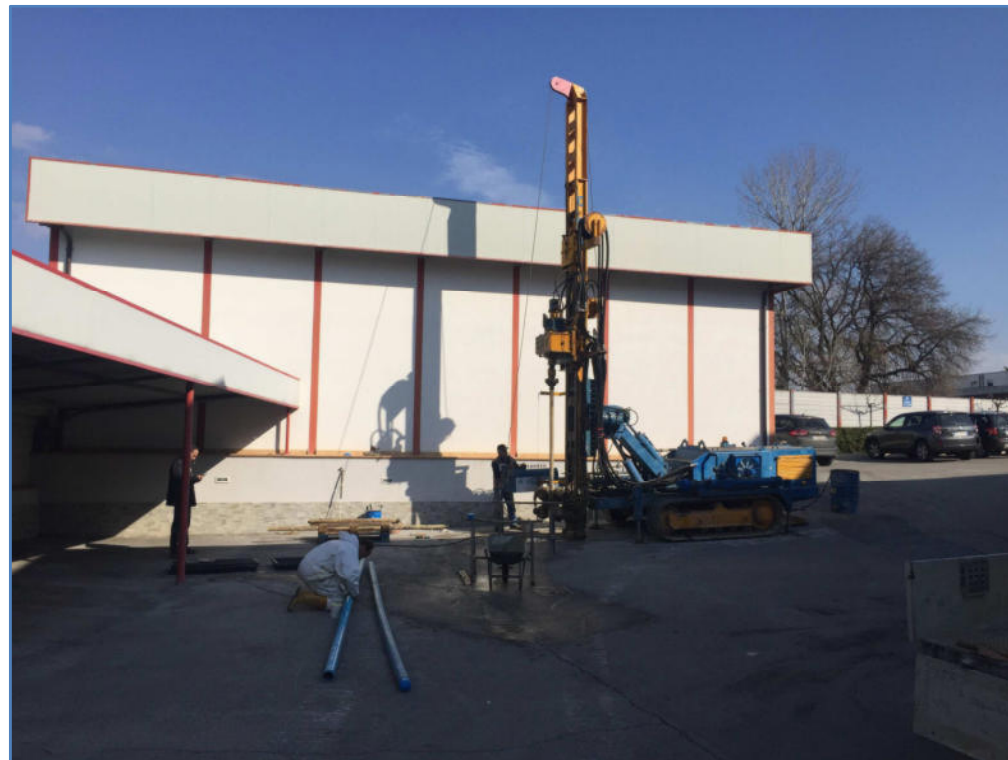
Installazione piezometro
