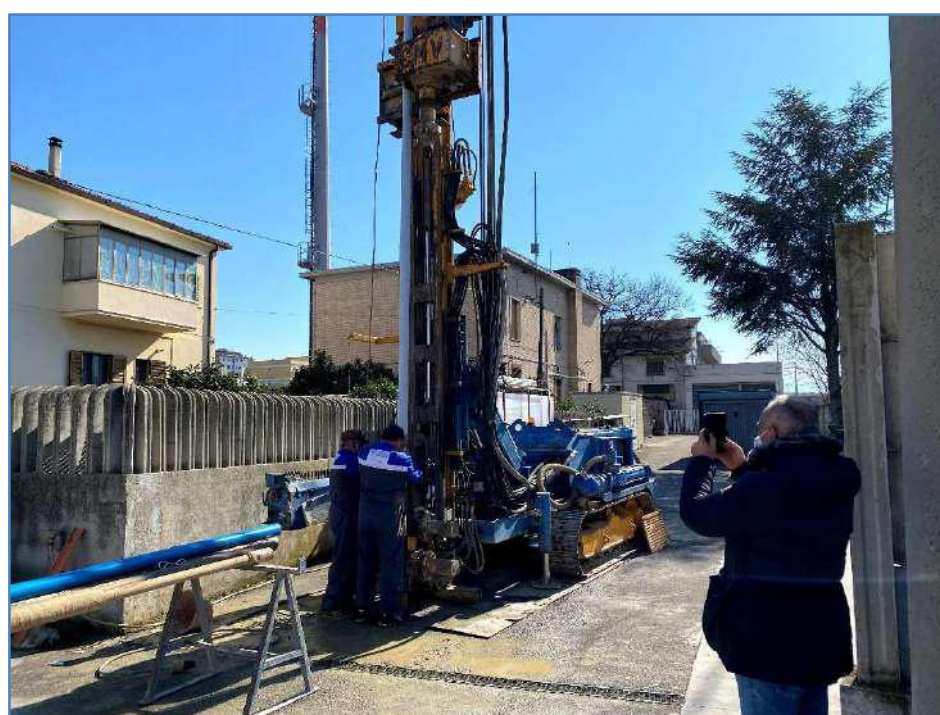
Installazione piezometro
